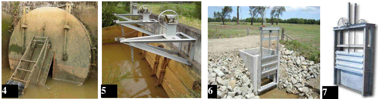
2.2.6 pav. Vandens tiekimo įrenginiai: 1-4 automatinės sklendės; 5-7 - šliuzai.
