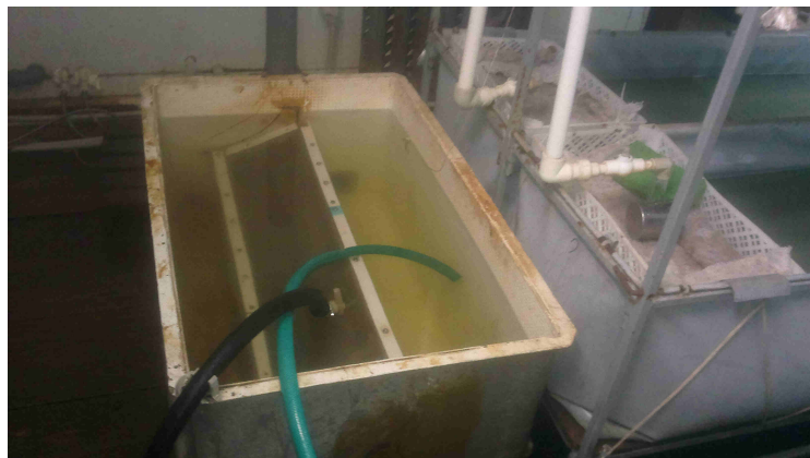
8.3.2.3.10. pav. Mechaninis filtras su stabiliu tinkliniu paviršiumi
