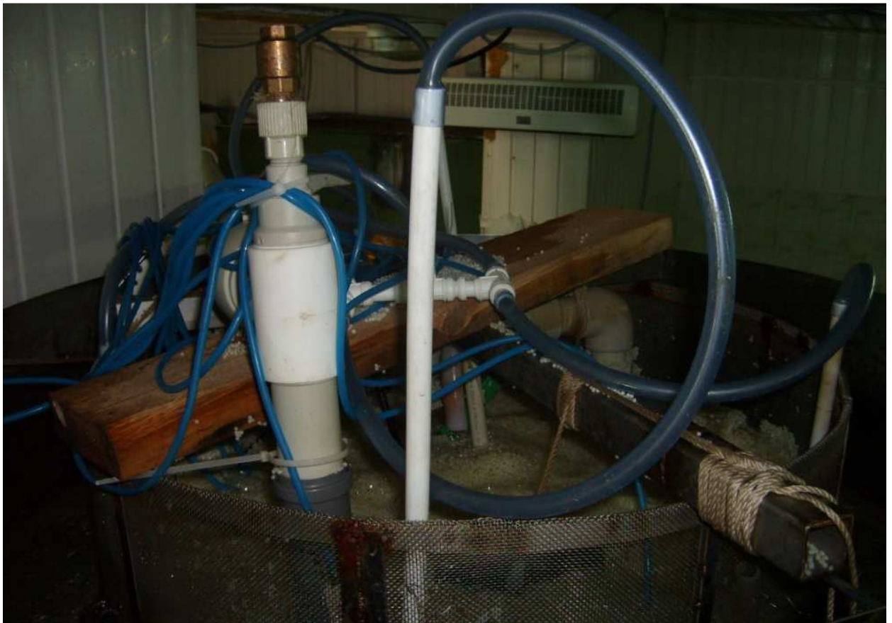
4.1.1.4 pav. Biofiltras, funkcionuojantis pagal bioreaktoriaus režimą
