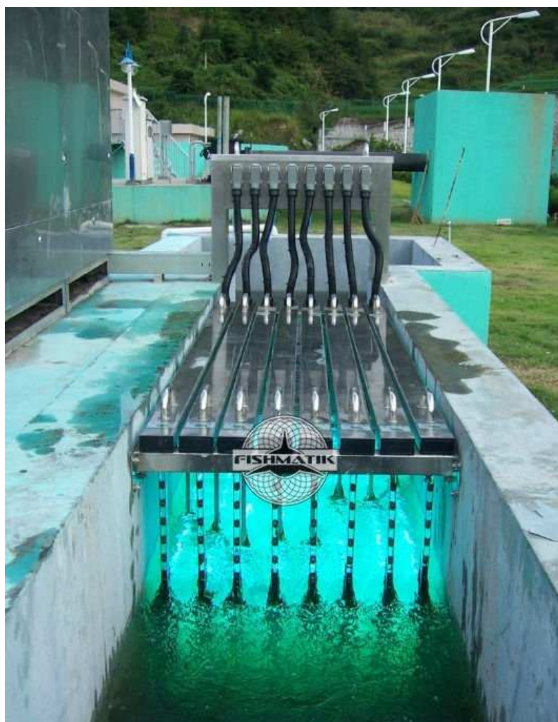
2.7.4 pav. Baktericidinių lempų autonominės kasetės.
