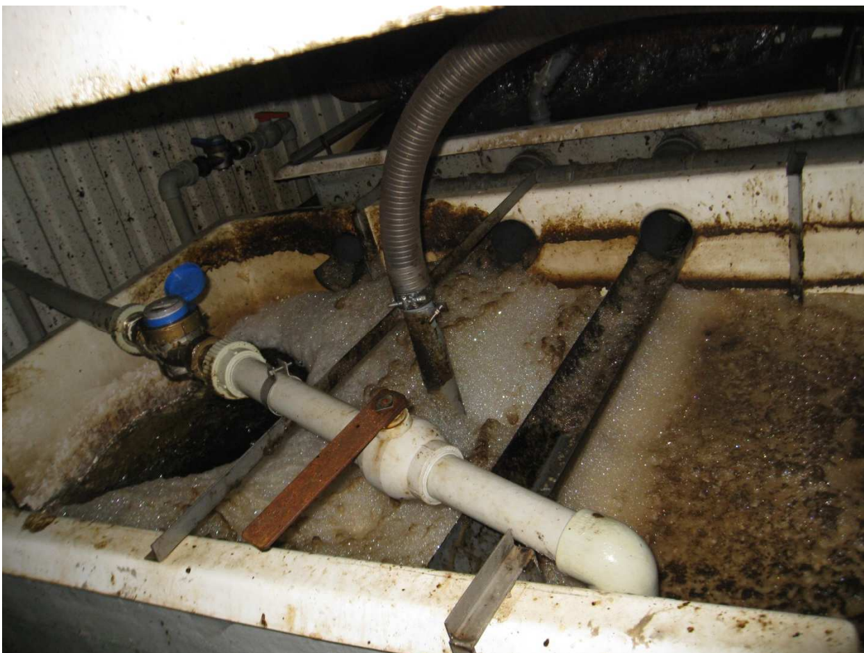
2.4.1 pav. Degazatoriai.
