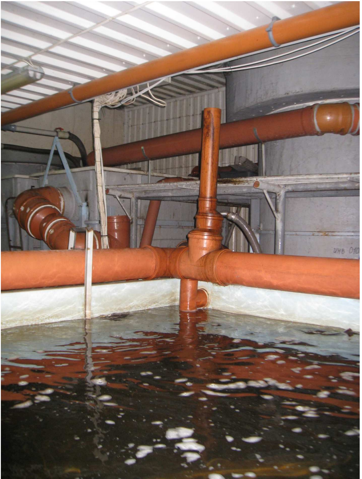
2.4.2 pav. Vėdinimo šachta.
