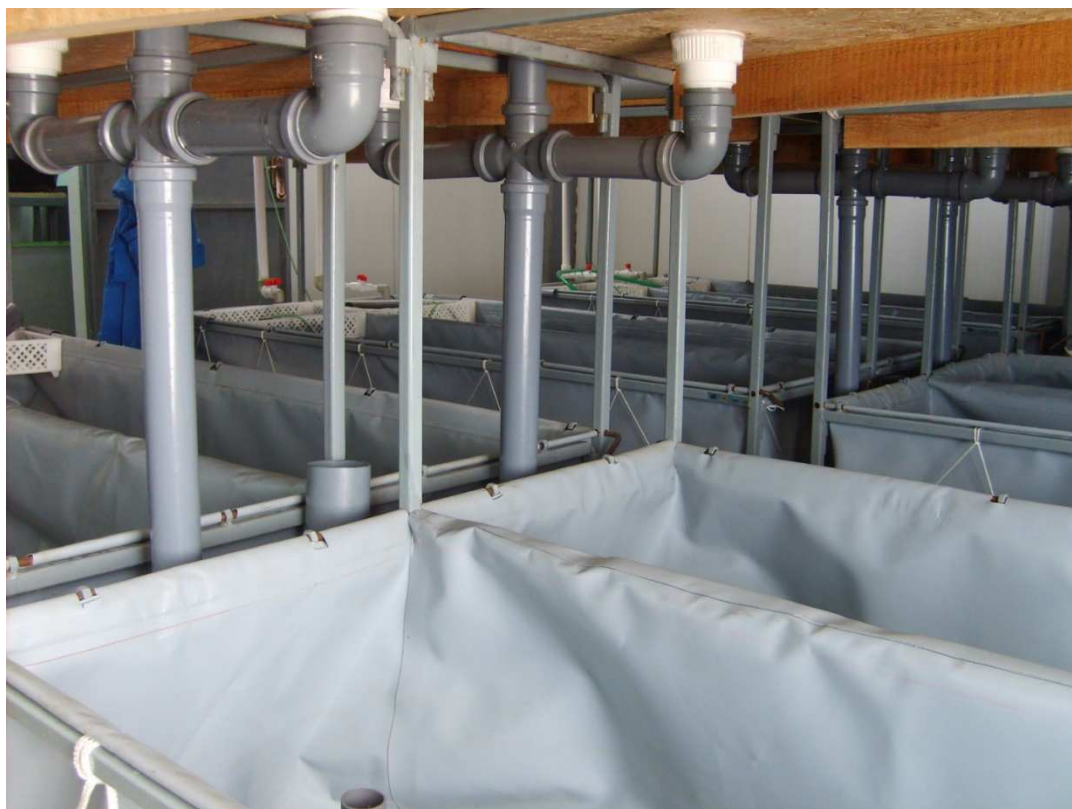
3.4.2 pav. Lervų laikymo ir paauginimo baseinas.
