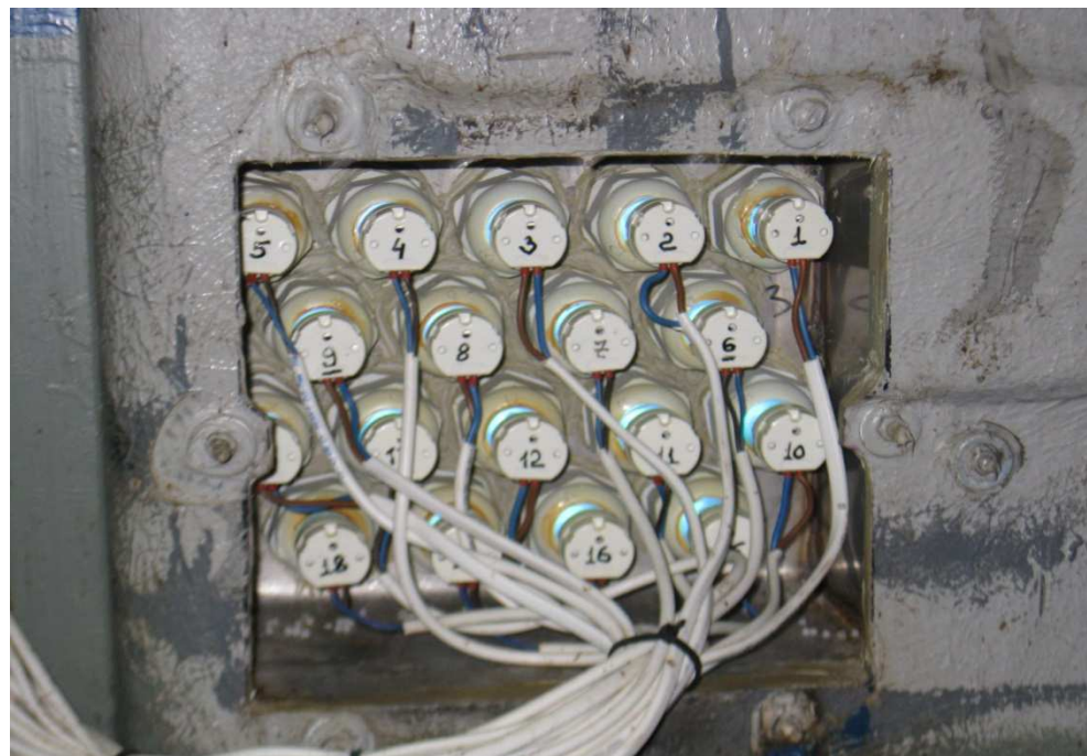
2.7.4 pav. Baktericidinių lempų autonominės kasetės.
