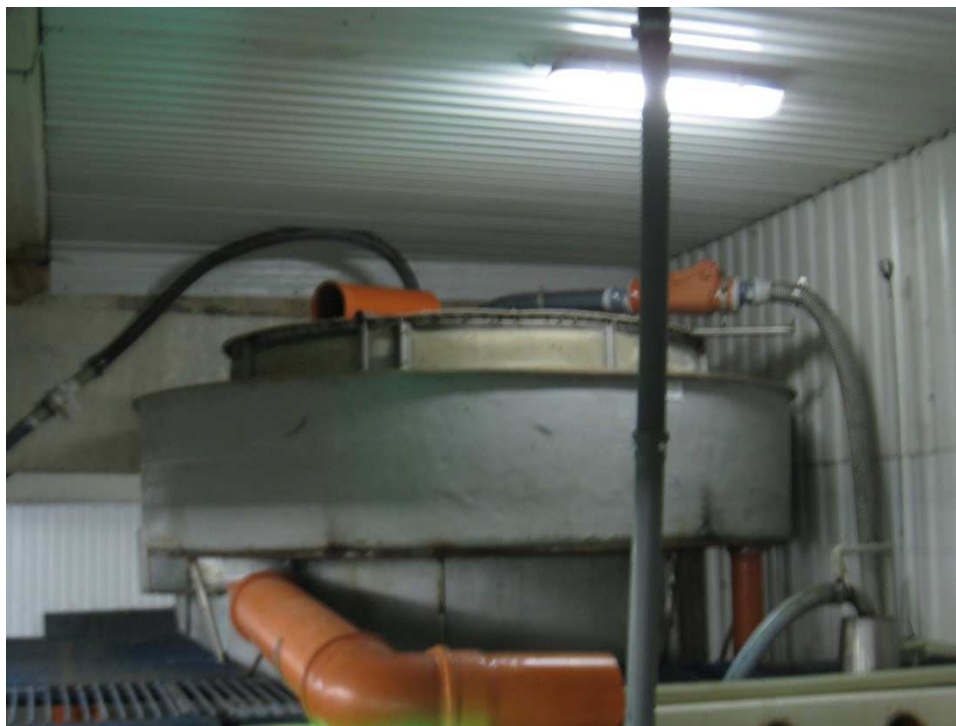
2.2.4 pav. Plūduriuojančios įkrovos filtras.
