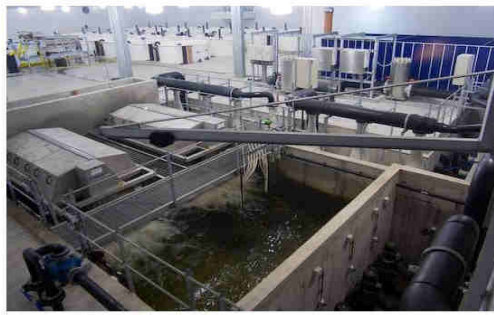
Klasikinės fermos tipo uždarojo apytakos ciklo sistema (RAS)
